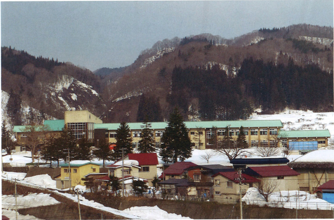
旧西目屋村小学校をリノベーションしたブナコ西目屋工場。
